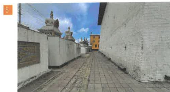
Гандантэгчэнлин хийдийн хойд талын явган зам талбай нь хэлбэржүүлсэн өнгөт хавтан хучилттай ба эвдэрч, хагарсан байдалтай
