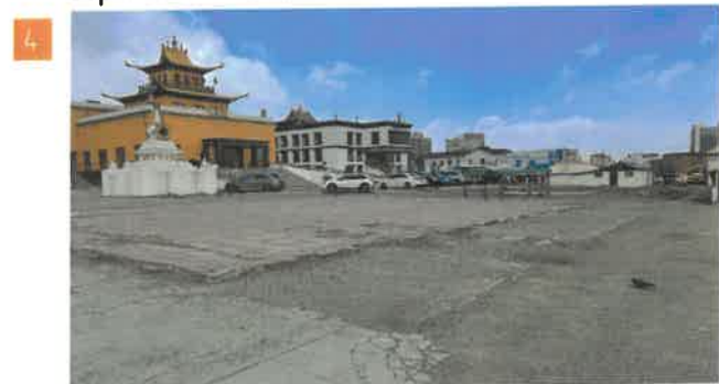
Талбайн гол хэсэгт, баруун зүүн талд нь 300*300 хэмжээтэй хэлбэржүүлсэн өнгөт хавтан хучилттай ба эвдэрсэн байдалтай
